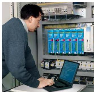
Con la **funzione di diagnosi** si può stabilire velocemente, mediante notebook, la causa di un guasto. La valutazione dei "dati di errore" mediante POSITool aiuta il tecnico a localizzare velocemente l'effettiva causa. Se un inverter non funziona più a causa di sovraccarico o di un guasto, frequentemente il problema si nasconde da un'altra parte.
